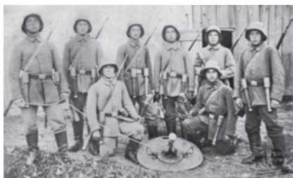
Den ursprungliga Granatenwerfer 15 med sin större runda bäddningsplatta.
