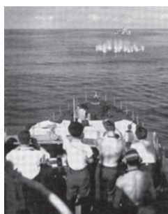
Bild 9. En Hedgehog-salva slår ned i en ring 200 m framför ett eskortfartyg.
