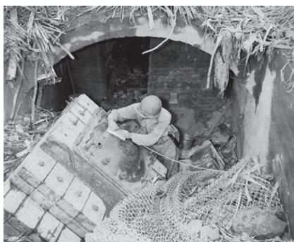
Bild 10. "Underredet" till en Mörsare Typ 98 med tillhörande timmerbäddning i ett förstört värn på Iwojima efter den amerikanska erövringen av ön.
