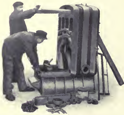
Öntöttvas kazán szerelése.
