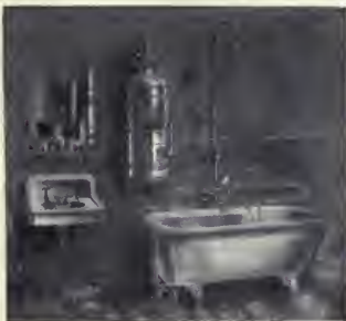
6. sz. ábra. Record-automatával kapcsolt fürdőberendezés fali csapteleppel.
