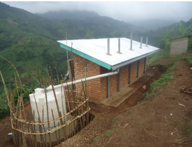
Latrine à 4 portes à l'EP Mabingu de Bitale
