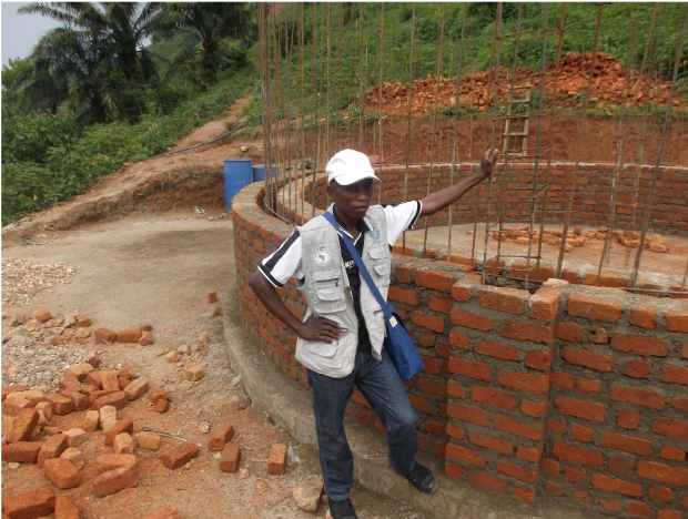
Supervision de la construction d'un réservoir d'eau à Chinganda.
