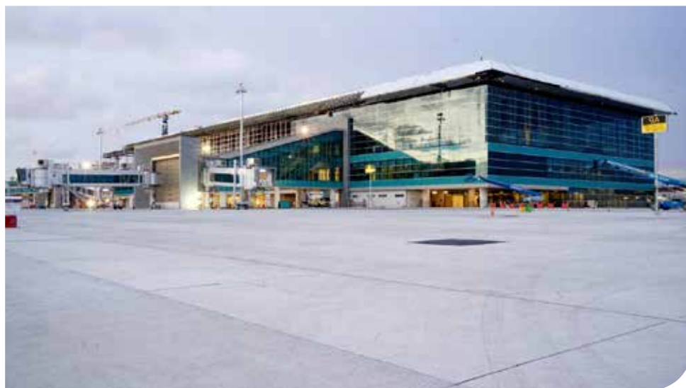
Bandara Internasional Yogyakarta di Kulon Progo, salah satu proyek pembangunan bandara yang akan tuntas tahun ini.
