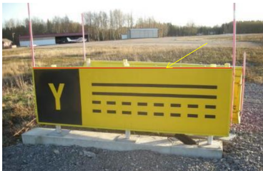
Posisjon / venteposisjon type A rullebane på Sandefjord lufthavn, Torp
