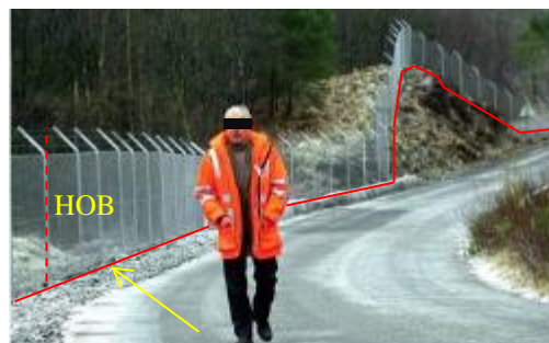
Eksempel på lufthavngjerde rundt Flesland lufthavn.
