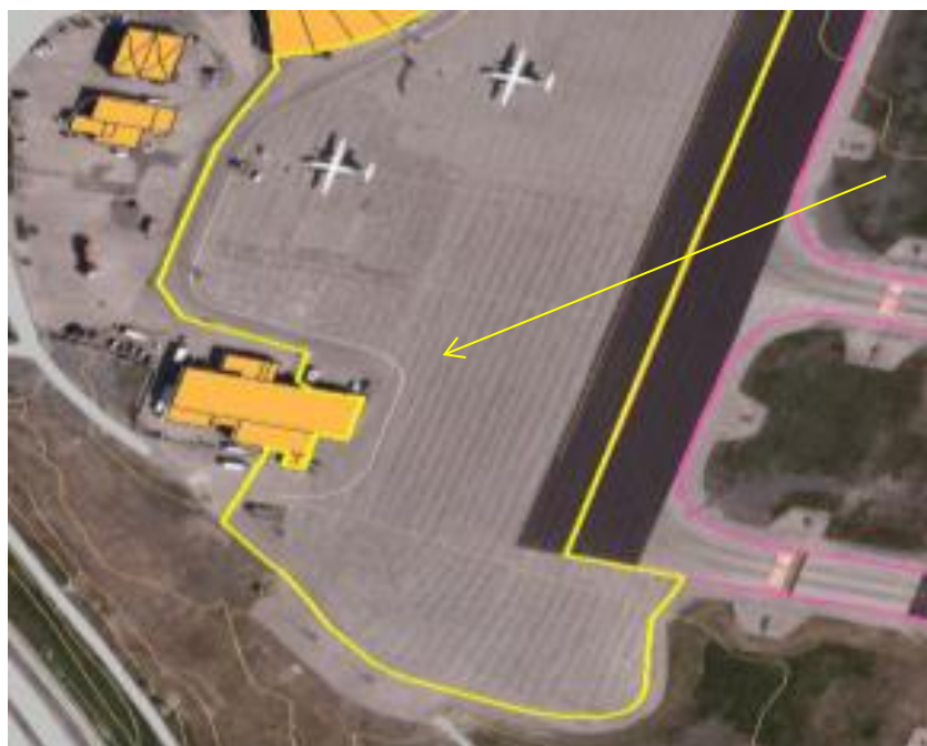
Inventar oppstillingsplattform (her markert i gult) på Tromsø lufthavn, Langnes.
