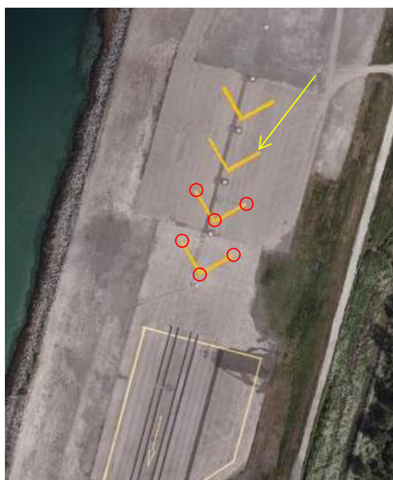
Piler for ubrukbart område på Tromsø lufthavn, Langnes
