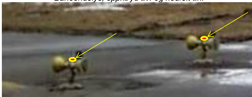
Baneendelys og terskellys blir ofte kombinert på siden av oppmerking av terskel. Det som skiller dem i flybilder er at terskellys peker i innflygingretning, mens bane-ende peker innover mot rullebanen.
