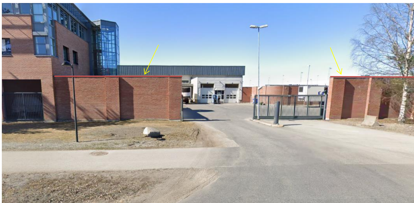
Sikkerhetsmur på Oslo lufthavn, Gardermoen
