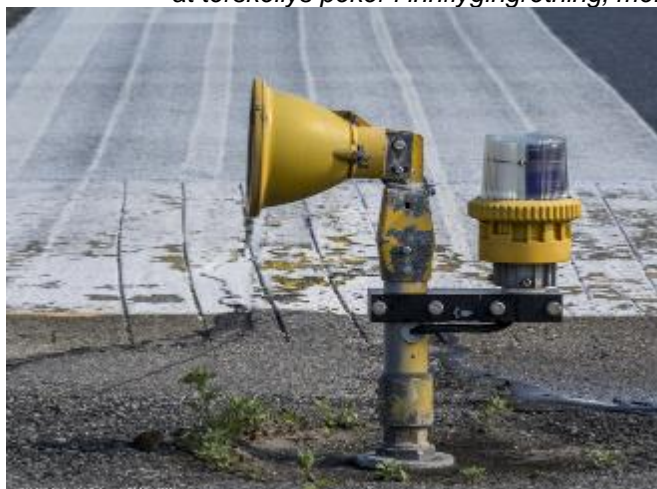
T.v. Kombinert terskellys og rullebanekantlys på Stavanger lufthavn, Sola.c
