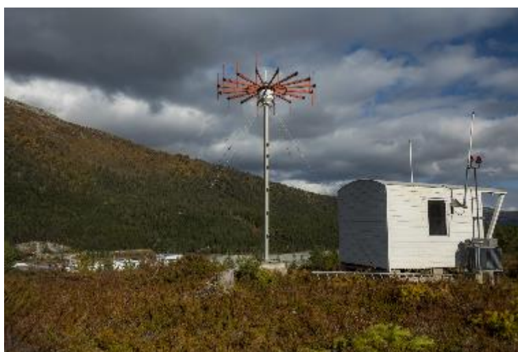
Peiler VDF på Sogndal lufthamn, Haukåsen
