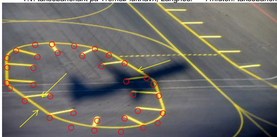
Forsterket taksebanekant på Oslo lufthavn, Gardermoen
