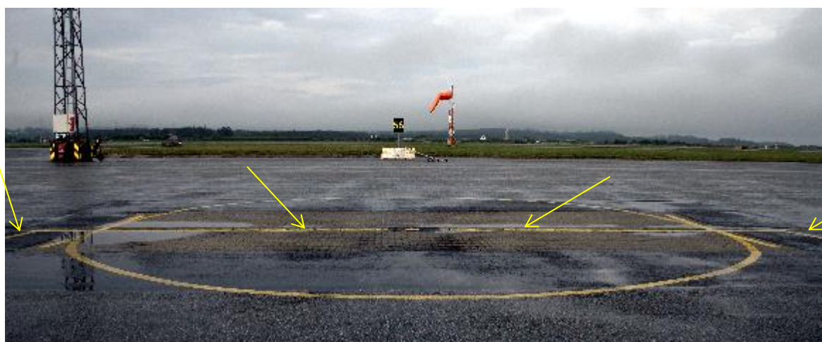
Eksempel på ledelinje ved helikopteroppstillingsplass på Stavanger lufthavn, Sola
