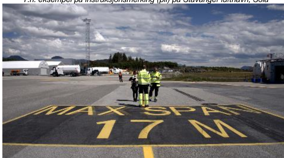
Eksempel på Instruksjonsmerking på Florø lufthavn Andre former for instruksjonsmerking kan forekomme.
