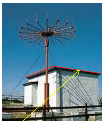
Peiler (VDF eller UDF antenne) T.v. med LufthavnInstrumenthytte. T.h. eksempel fra Tromsø lufthavn, Langnes
