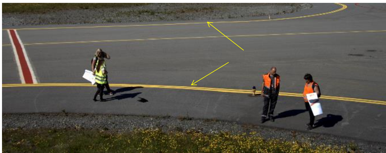
Eksempel på kantmerking (oppstillingsplattform) på Florø lufthavn
