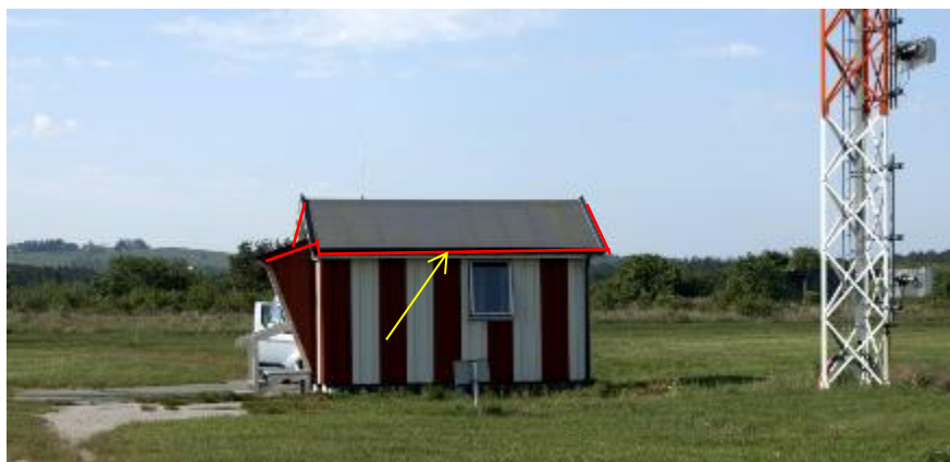
LufthavnInstrumenthytteKant på en LufthavnInstrumenthytte
