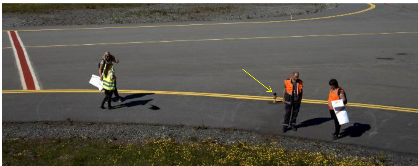
Taksebanekantlys på Oppstillingsplattform på Florø Lufthamn.
