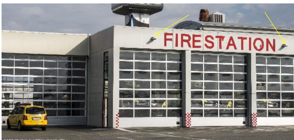
Flombelysning på vegg på Stavanger lufthavn, Sola
