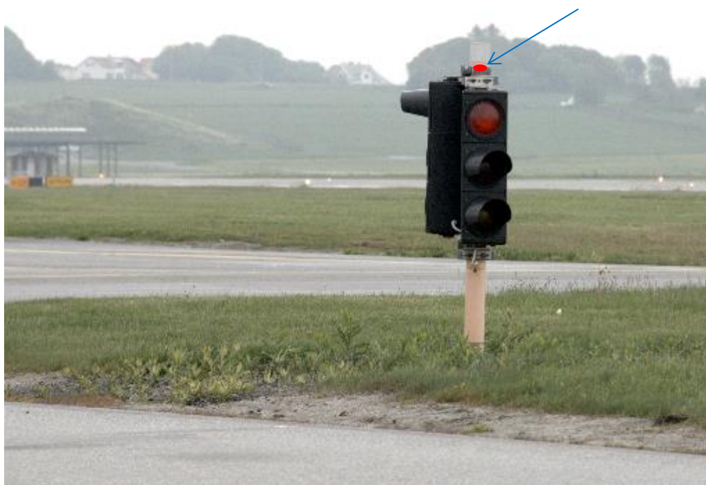
Venteposisjonslys for kjøretøy på Stavanger lufthavn, Sola
