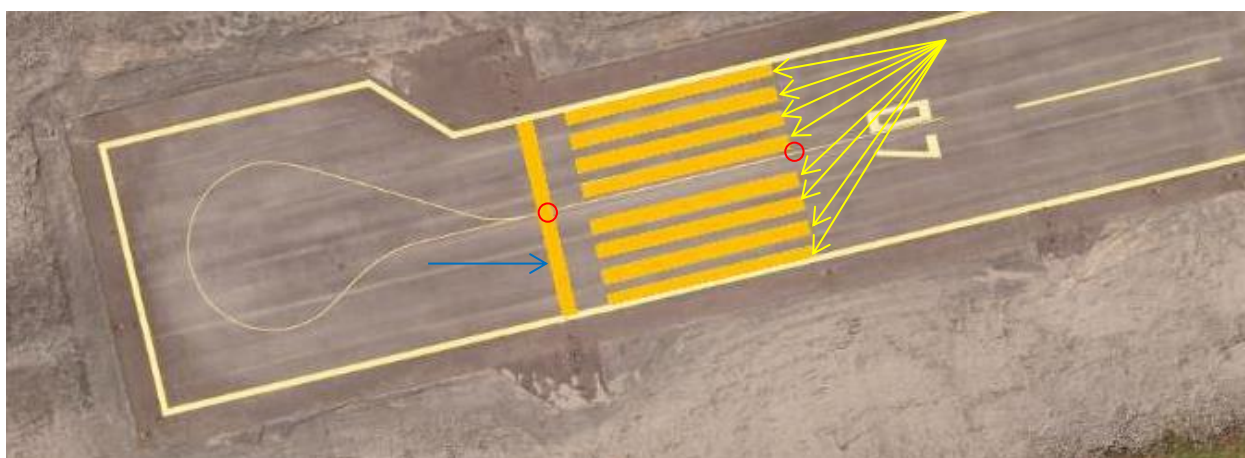
Terskel på Førde lufthavn, Bringeland
