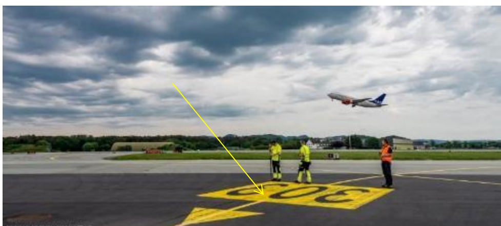
Eksempel på ny ID-markering på Stavanger lufthavn, Sola
