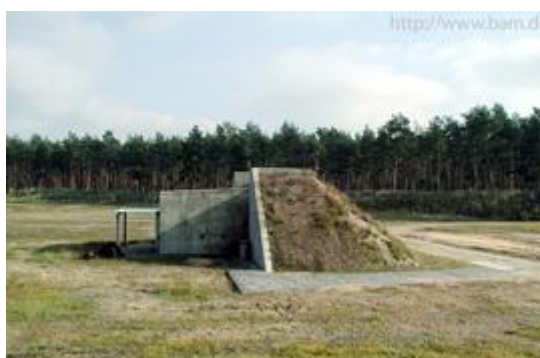
Eksempel på sprengkammer.
