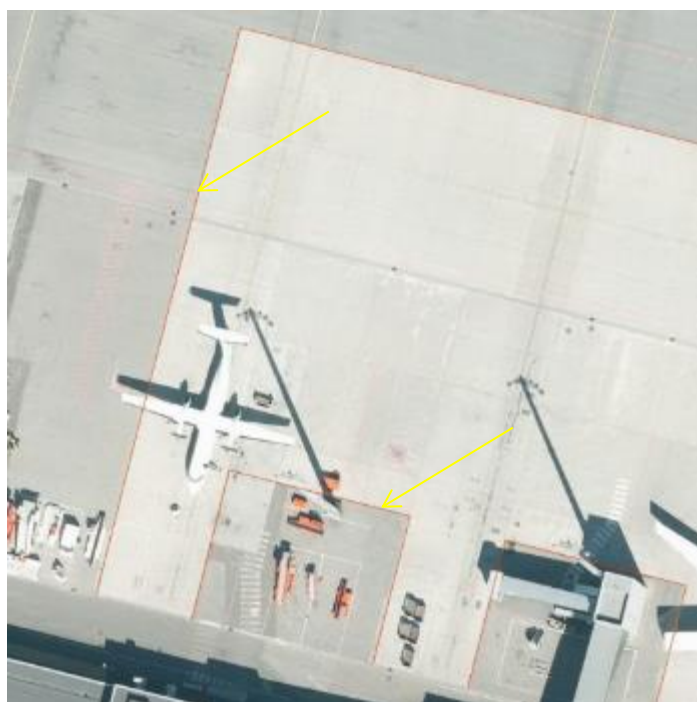
Skille asfalt/betong markert med røde linjer på Oslo lufthavn, Gardermoen.
