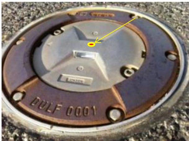
T.v. Rullebanesenterlinjelys T.h. Rullebanesenterlinnelys med 15 meters avstand på presisjonsrullebane 18 (CAT II) på Stavanger lufthavn, Sola.
