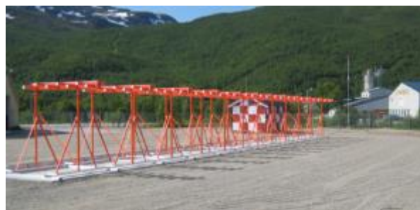
Eksempel på LOC-anlegg i flybilde på Bergen lufthavn, Flesland Øverst: Skisseform på hvordan de enkelte element registreres Nederst: Bilde av et LOC-anlegg på Sørkjosen lufthavn
