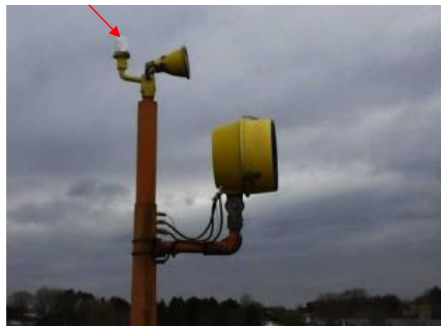
Innflygingslys plasseres i senterlinjen for innflyging. Mange kombinasjonsmuligheter vil finnes i praksis.
