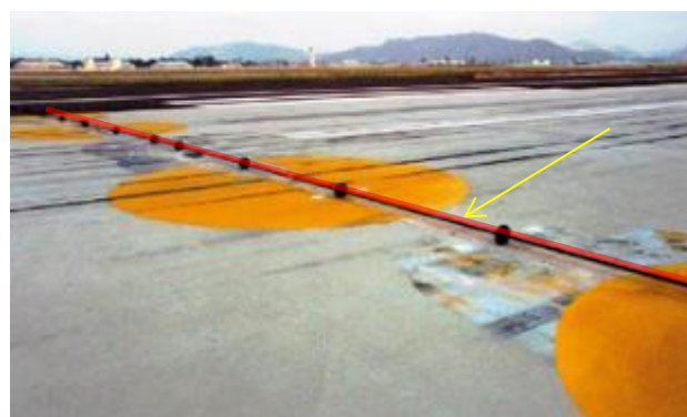
Arresting gear (stop wire) på Bodø lufthavn. Røde linjer skal registreres (både vaieren og festeanretning). Festeanordningen i endene skal registeres som flate.
