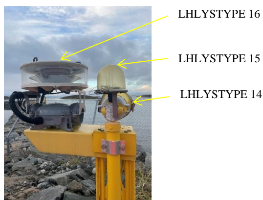
Innflygingsblinkfyr på Rørvik lufthavn, Ryum. Plasseres i senterlinjen for innflyging.
