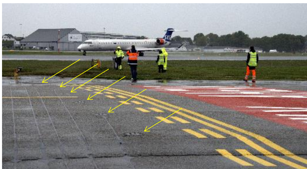
Stopplysrekke, nedfelt lys på Stavanger lufthavn, Sola
