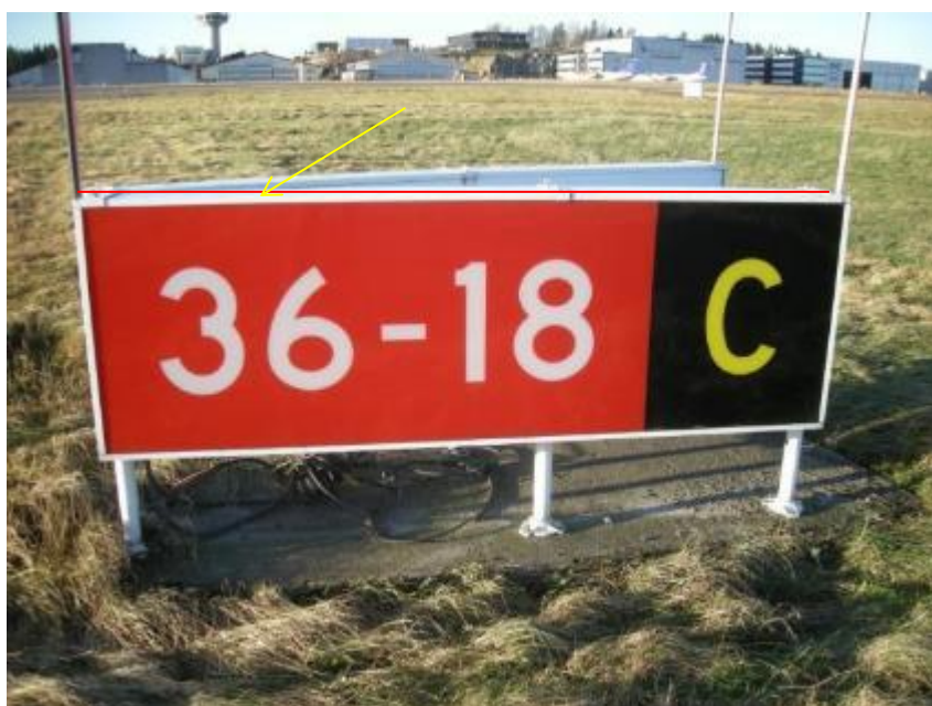
Posisjon / venteposisjon rullebane-skilt på Sandefjord lufthavn, Torp
