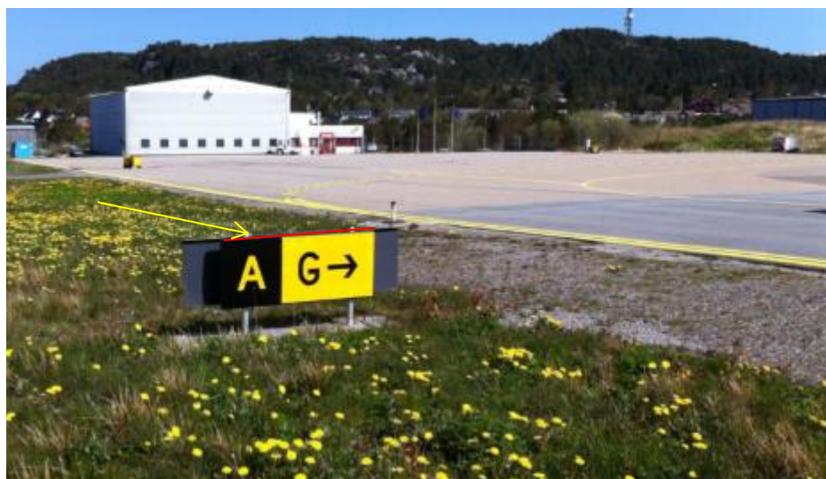
Posisjon / retnings-skilt på Florø lufthavn
