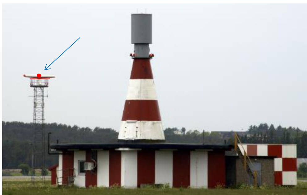
Eksempler på bakkeradar på Stavanger lufthavn, Sola
