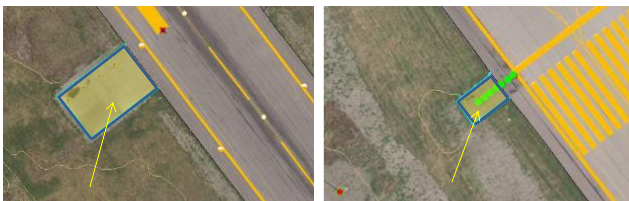
Areal rundt navigasjonsanlegg på Haugesund lufthavn, Karmøy
