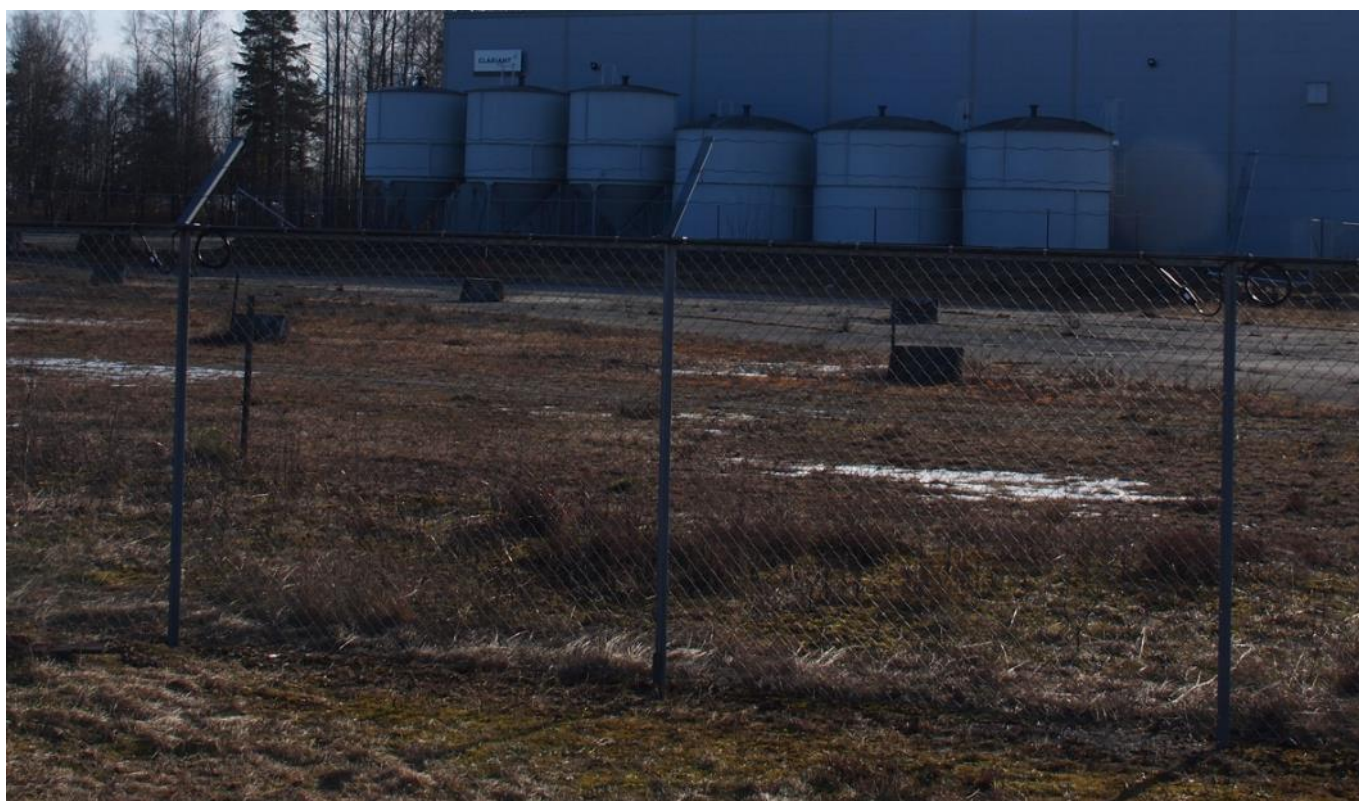
Industrigjerde på Oslo lufthavn, Gardermoen
