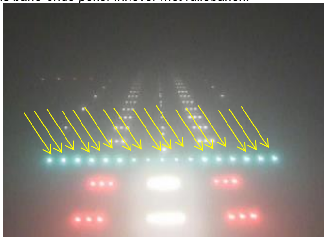
T.v. Kombinert terskellys og rullebanekantlys på Stavanger lufthavn, Sola.c
