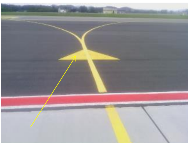
T.v. eksempel på instruksjonsmerking (kryss) på Kristiansand lufthavn, Kjevik T.h. eksempel på instruksjonsmerking (pil) på Stavanger lufthavn, Sola
