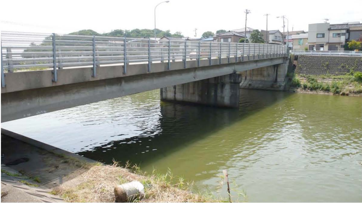
Fig. 6.57. The Ukawa Bridge.
