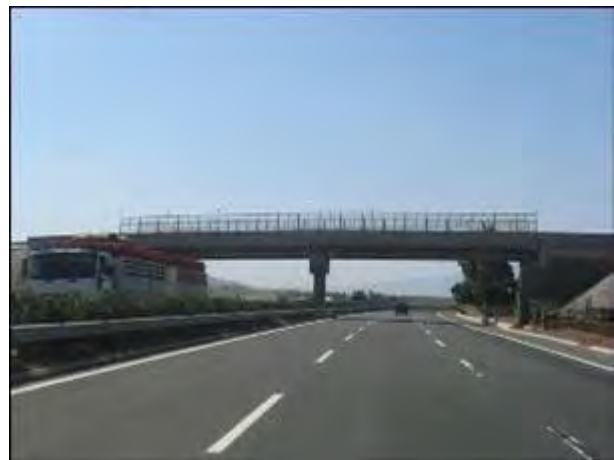
車道と跨道橋
