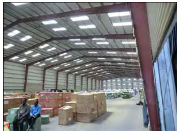
税関用倉庫の内部
