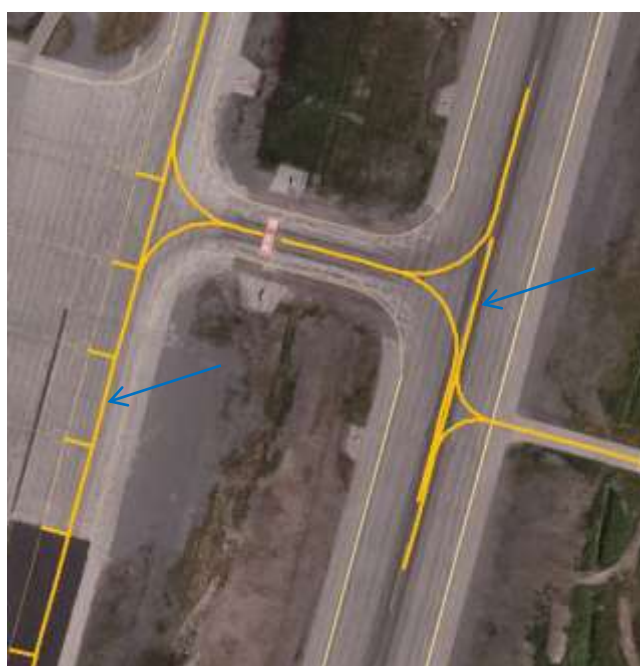
Senterlinje (taksebane) på Tromsø lufthavn, Langnes
