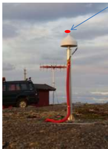
Eksempel på IMS/GRS-mottakere på et SCAT-I anlegg. T.h. instrumenthytte med VHF-antenne i bakgrunnen.
