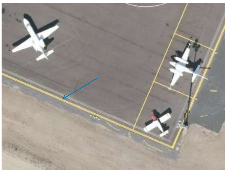
Eksempel på kantmerking (plattform) på Alta lufthavn
