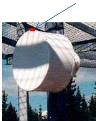
Eksempel på parabol – registreres i rødt punkt
