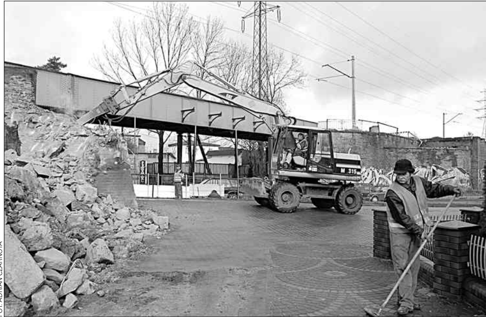
Kilka dni temu pełną parą ruszyły prace rozbiórkowe na wiadukcie na ul. Mikołowskiej
