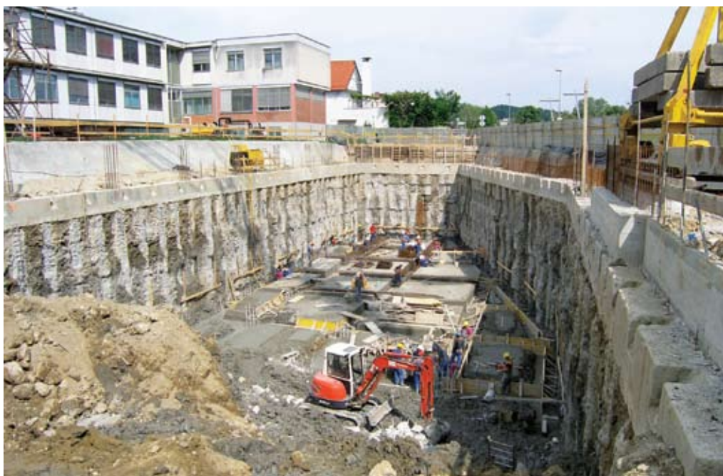
Pogled v zavarovano gradbeno jamo ob Finžgarjevi ulici v Ljubljani.
