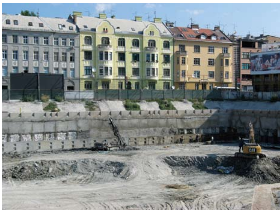
Pogled na izkop gradbene jame za objekt Marijin dvor v Sarajevu. Projektirano dna izkopa bo še ca 12 m nižje.
