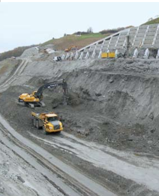
Gradnja globokega avtocestnega vkopa v miocenskem laporju v Dragučovi sodi po vseh merilih med najzahtevnejša zemeljska dela.
