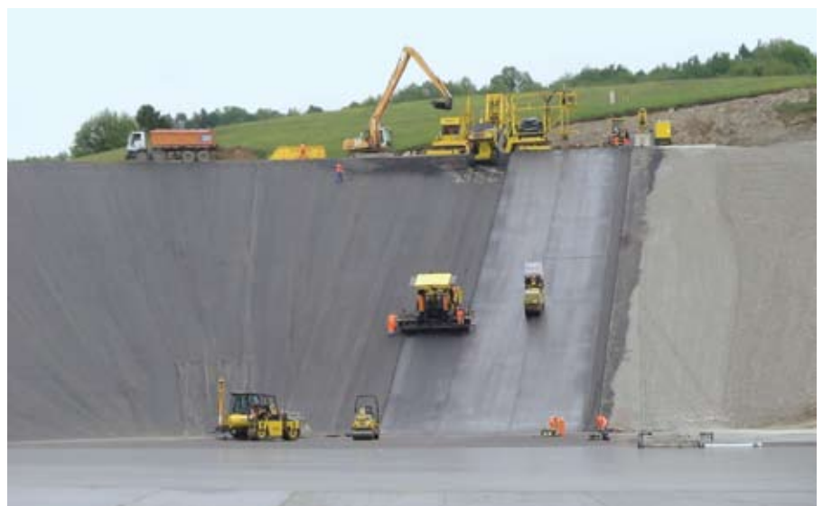
Tesnjenje brežin z asfaltno oblogo.
