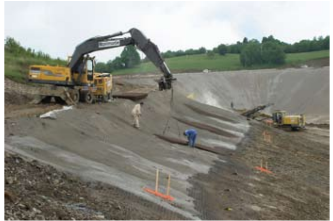
Prikaz AccuGrade na buldozerju D6K XL, v ozadju položena tamponska plast čaka na asfaltno tesnjenje in sanacija ploskovnega zdrsa na flišni brežini bodočega bazena
