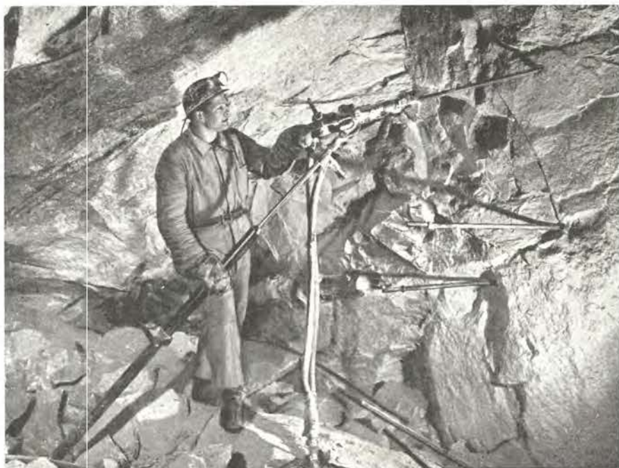
Underjordisk brytning av kalksten; bergbore i Montola gruva.
