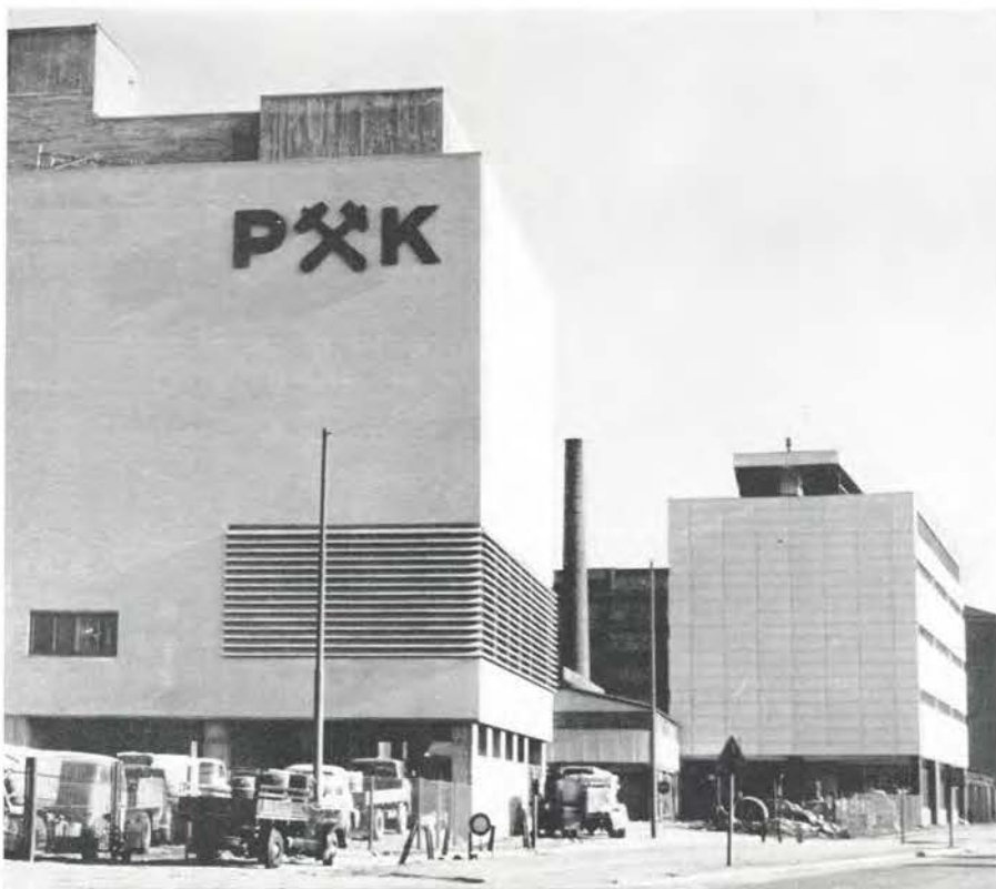
Den nya murbruksfabriken i Helsingfors, Sörnäs. Observera gallret av specialformade mineritskivor
