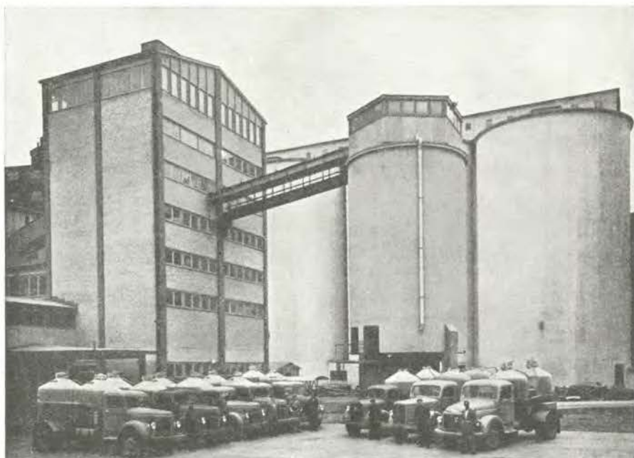
Cementstationen i Helsingfors med löscementbilar och silor
