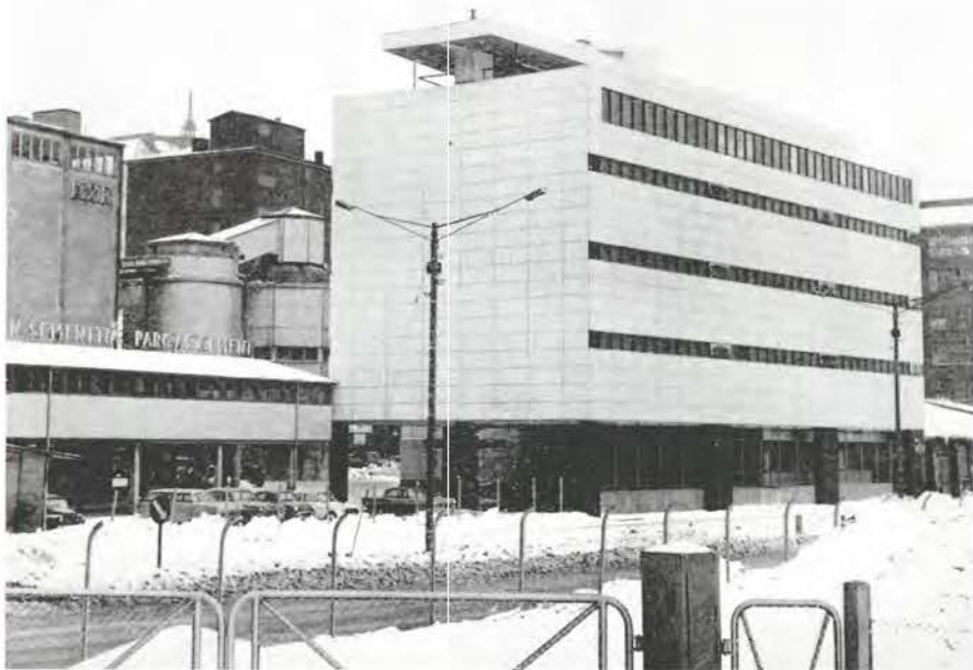
Den nya verkstads-, lager- och kontorsbyggnaden vid Sörnäs Strandväg i Helsingfors.
