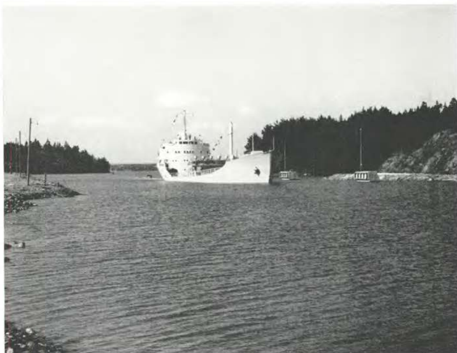
Den 23 juli 1962 passerade M/S Granvik som första fartyg den fördjupade och uträtade 22' farleden genom Tervsund till Pargas.
