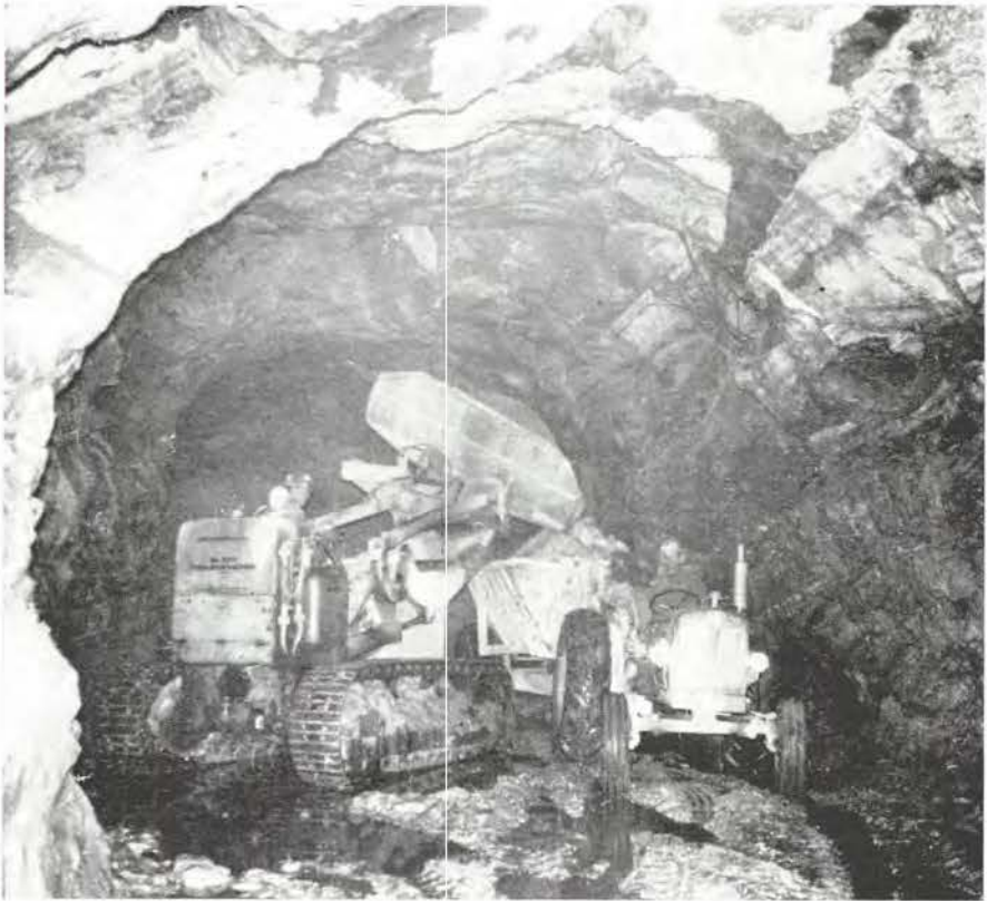
Loukolampis underjordiska kalkstensbrytning i Montola är i hög grad mekaniserad.
