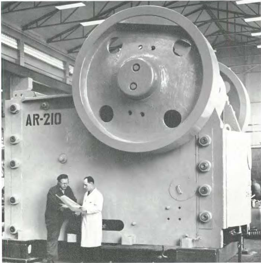
Två tunga maskiner: Här ovan en ny stenkross för gruvan i Pargas. Den är störst i Norden av denna typ och tillverkad av A. Ahlström Osakeyhtiös Karhula Verkstad. Intagsöppningen är 2130 × 1500 mm och den kommer att tugga 800–900 ton kalksten i timmen. Krossen väger c. 155 ton. På vidstående sida den nya plattpressen i Muijala Mineritfabrik. Den har presskraften 14.000 ton och hör därmed till de största i Europa.
