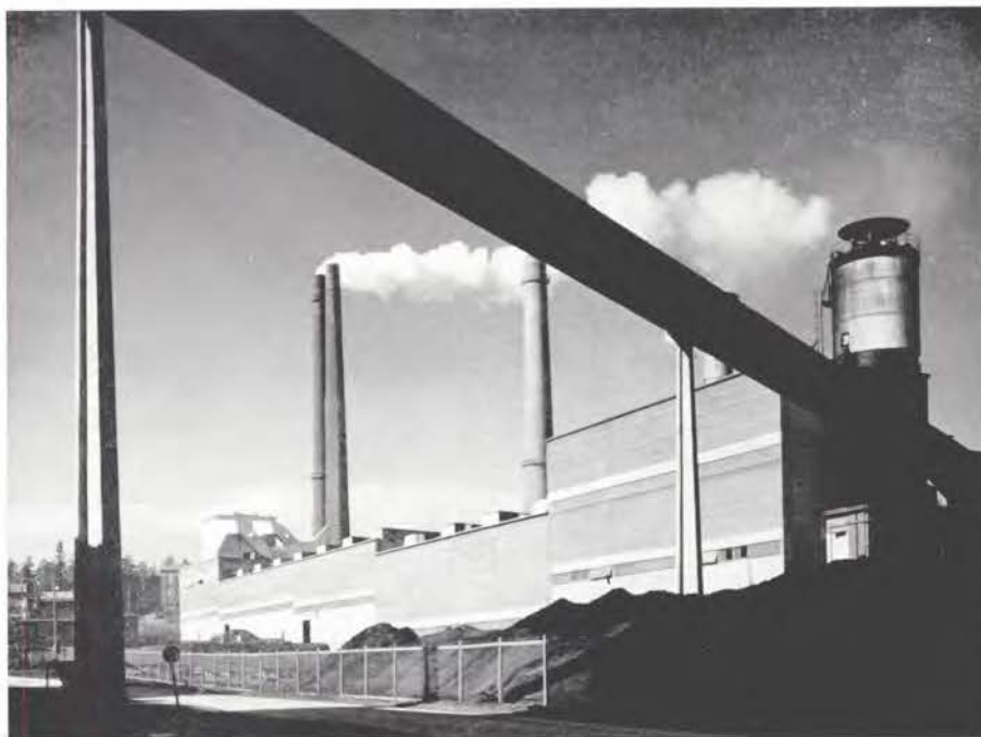
Den 200 m långa fasaden till det nya cementugns huset i Pargas är byggd i fabriksstillverkade betongelement och kalkmursten. Den nya ugnens elektrofilter för rening av rök-gaserna är placerade på taket invid skorstenarna.
