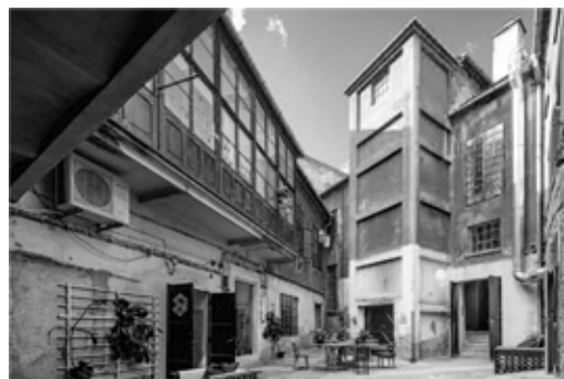
Obr. 2.: Nádvoří objektů The Distillery (Zdroj: www.ticbrno.cz)
