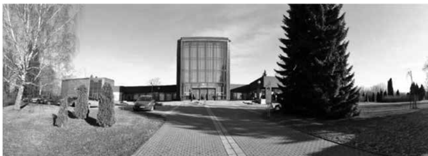
Obr.2, nepříjemně dlouhá vstupní pěší trasa ke krematoriu hřbitova na Slezské Ostravě
