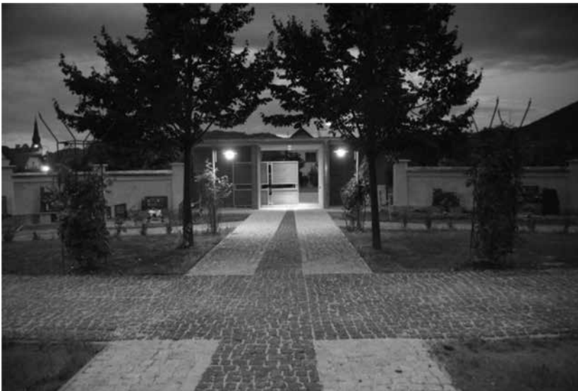
Obr.10, Fotografie realizované rekonstrukce hřbitova v Rapotíně, 2017 Zdroj : foto autor
