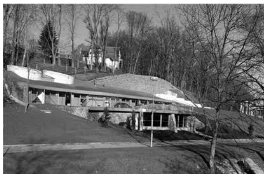
Obr. 3.: Čistírna odpadních vod Náměstí nad Oslavou. Zdroj: autorské foto
