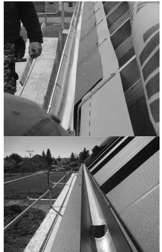
Picture 8-9.: Photos of construction progress (Zdroj: 3AE s.r.o.)
