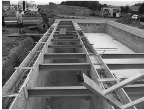
Obr. 12 Průběh realizace – technický prostor u bazénu (foto: M. Nedvěd)
