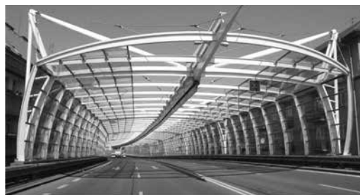
Obr. 7.: Protlukový tunel městského obchvatu v Hradci Králové Zdroj: autorské foto
