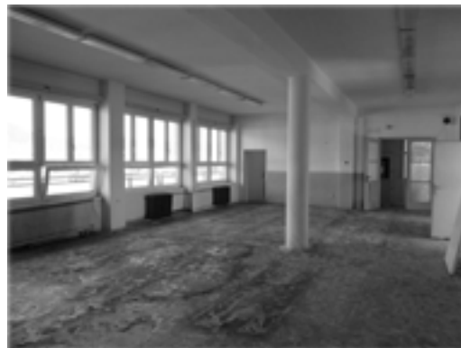
Obr. 9.: Priestory objektu školy krátko po tom, čo sa ho podarilo získať Nadácii Cvernovka. August, 2016 (Zdroj: N. Bartošová).
