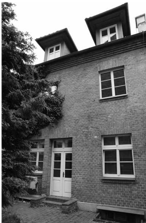
Obr. 2.: Pohľad na dvornú fasádu, Kapitulská 12, Bratislava, dvojitý prístup k riešeniu fasád v kontexte s prostredím (Zdroj: foto E. Borecká)
