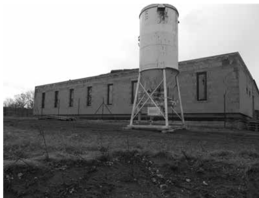
Obr. 14 Průběh realizace – pohled od vesnice – urbánní stěna (foto: M. Nedvěd)
