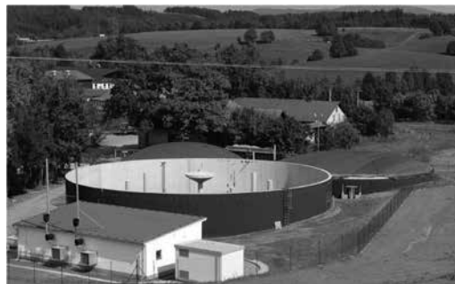
Obr. 6.: Bioplynová stanice Dolní Dobrouč Zdroj: autorské foto
