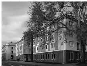
Ing. arch. Tomáš Bědi: Stavební úpravy objektu Gong, 2014 (Stavba Moravskoslezského kraje 2013) Ateliér 36
