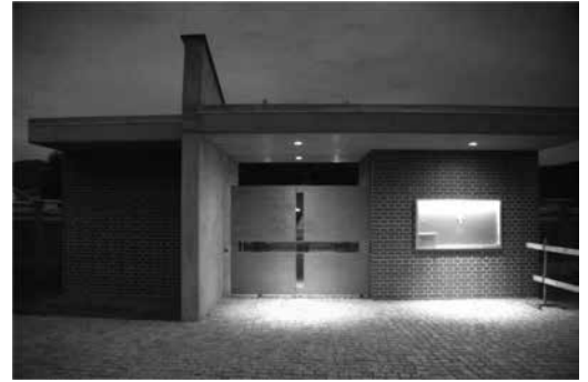
Obr.11, Fotografie realizované rekonstrukce hřbitova v Rapotíně, 2017 Zdroj : foto autor
