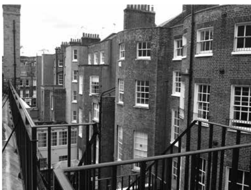
Obr. 6.: Budova školy AA, pohľad z vnútrobloku (Zdroj: autor)
