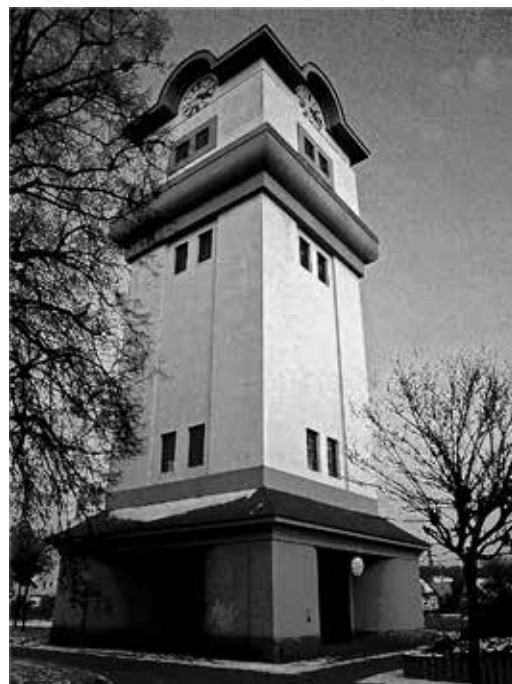
Obr. 1.: Vodárenská věž Týniště nad Orlicí, Zdroj: mapio.net
