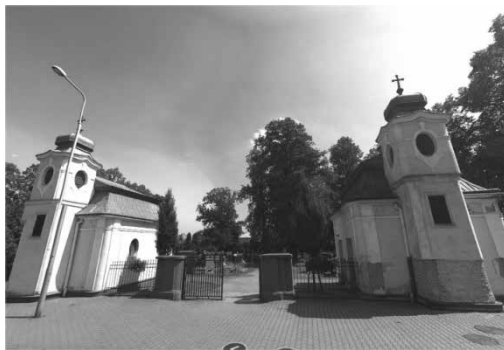
Obr.6, vstupní část s kaplemi hřbitova Ostrava Zábřeh Zdroj : foto autor
