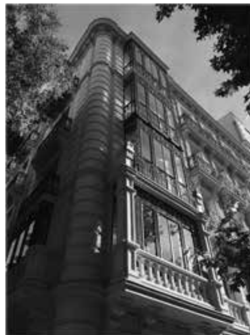
Obr. 1.: Tradičné zimné záhrady na fasáde bytového domu, Calle de Antonio Maura, Madrid
