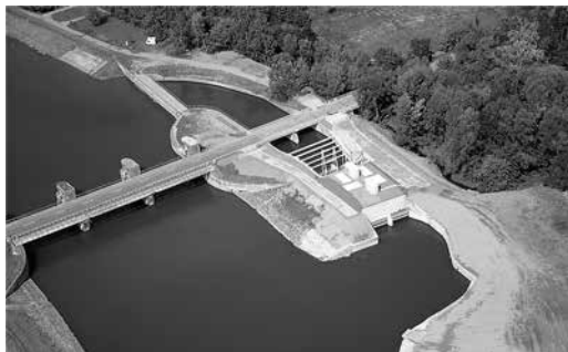
Obr. 5.: Malá vodní elektrárna Bělov na řece Moravě Zdroj: web - letecký snímek
