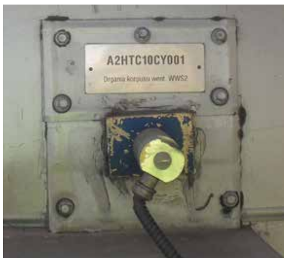
FOT. 1 Czujnik drgań nadzorujący stan dynamiczny wentylatora
