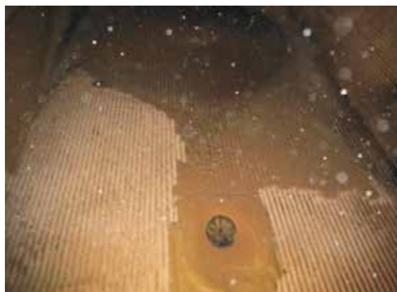
FOT. 1 Widok zanieczyszczonych powierzchni ogrzewalnych w komorze paleniskowej kotła w 100% opalanego biomasą (zdjęcie autora)
