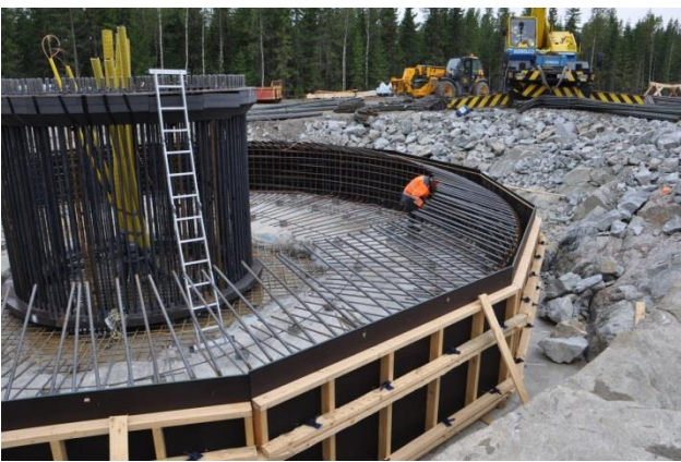
Kuva 5-12. Tuulivoimalan perustusten rakentamista (Leila Väyrynen, FCG).
