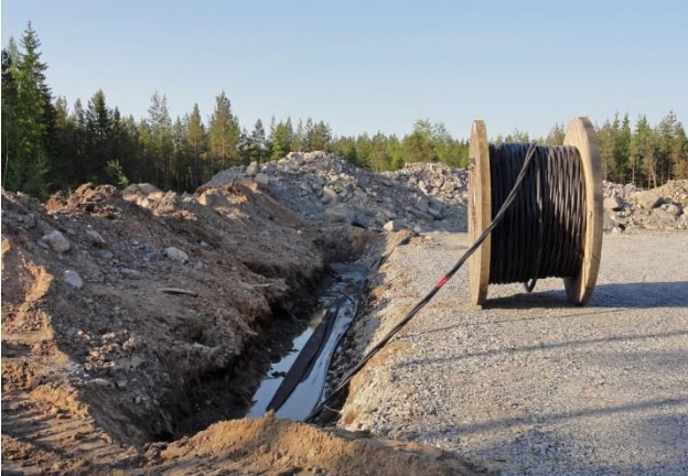
Kuva 5-11. Maakaapelit upotetaan huoltoteiden yhteyteen (Ville Suorsa, FCG).
