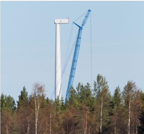
Kuva 5-13. Tuulivoimalan kokoamista (Ville Suorsa, FCG).
