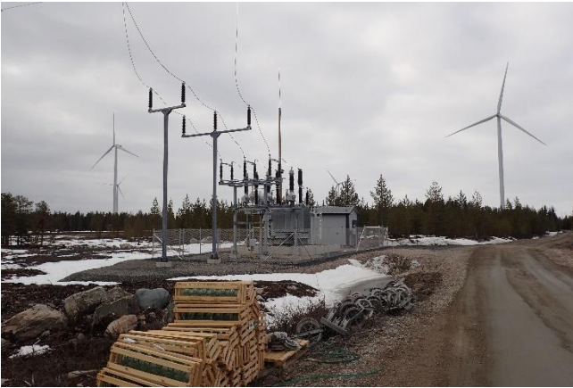
Kuva 5-15. Sähköaseman ja voimajohtojen rakentamista (Ville Suorsa, FCG).
