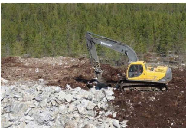
Kuva 5-10. Tuulivoimapuiston rakentaminen alkaa huoltoteiden ja pystytysalueiden rakentamisella (Ville Suorsa, FCG).
