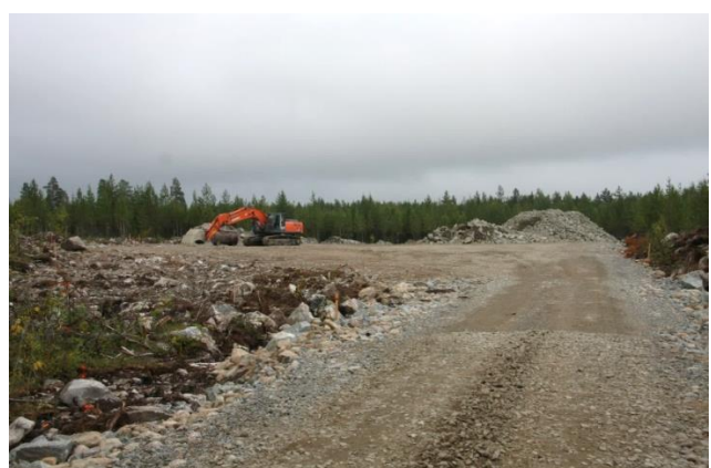
Kuva 5-10. Tuulivoimapuiston rakentaminen alkaa huoltoteiden ja pystytysalueiden rakentamisella (Ville Suorsa, FCG).
